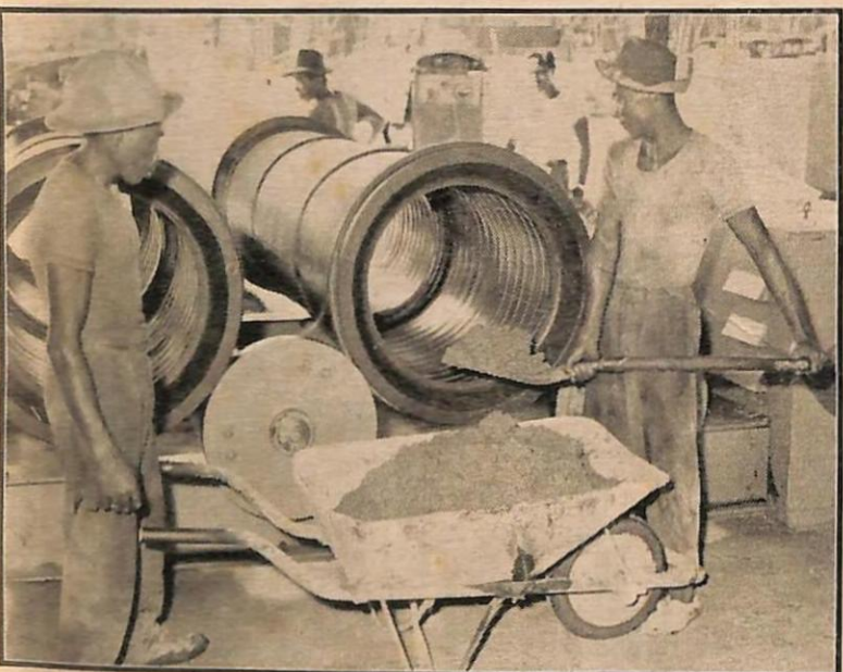
Gambar di-atas menunjukkan pekerja2 kilang paip ayer sedang menyiapkan paip2 yang di-buat di-situ.
