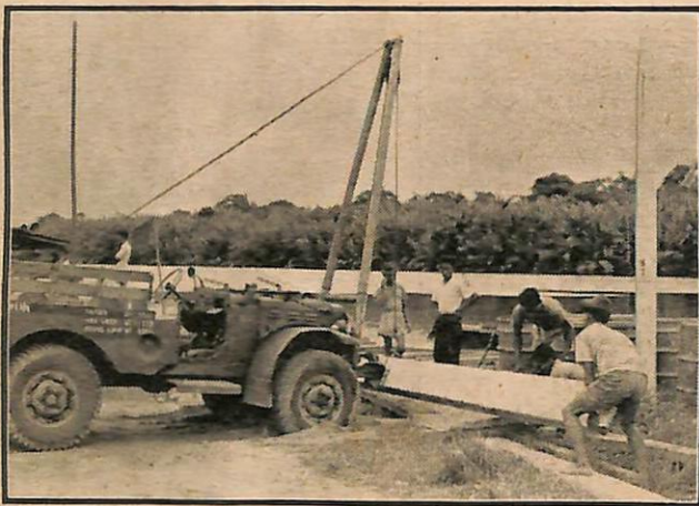
Bawah: Pekerja2 kelihatan mendirikan tiang untuk tebing sungai Tutong.
