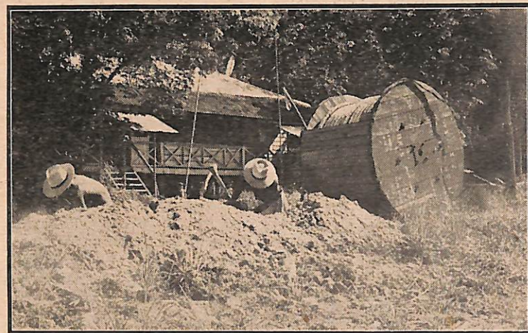
Di-atas, beberapa buah transformer telah di-dirikan di-tepi2 jalan yang menghubungkan pusat electric Bandar Brunei dengan kampung2. Transformer2 itu ia-lah untuk menguatkan tenaga electric. Gambar di-bawah, ini menunjukkan pekerja2 Pejabat Electric Brunei menggali parit supaya cable atau kawat electric di-bawah tanah itu dapat di-tanamkan kelak.
