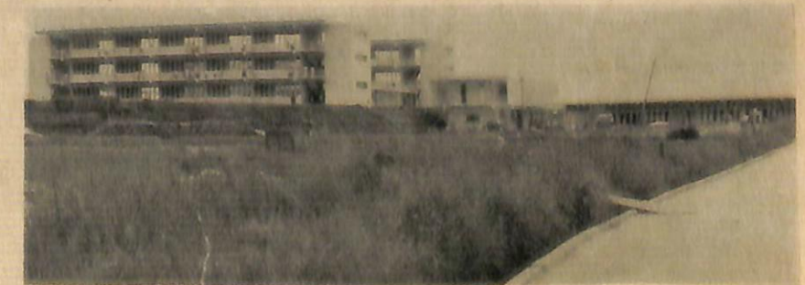
Pemandangan bangunan S.M.J.A. Pusar Ulak. Di-sabalah kanan ia-lah bangunan dewan besar sekolah itu.
