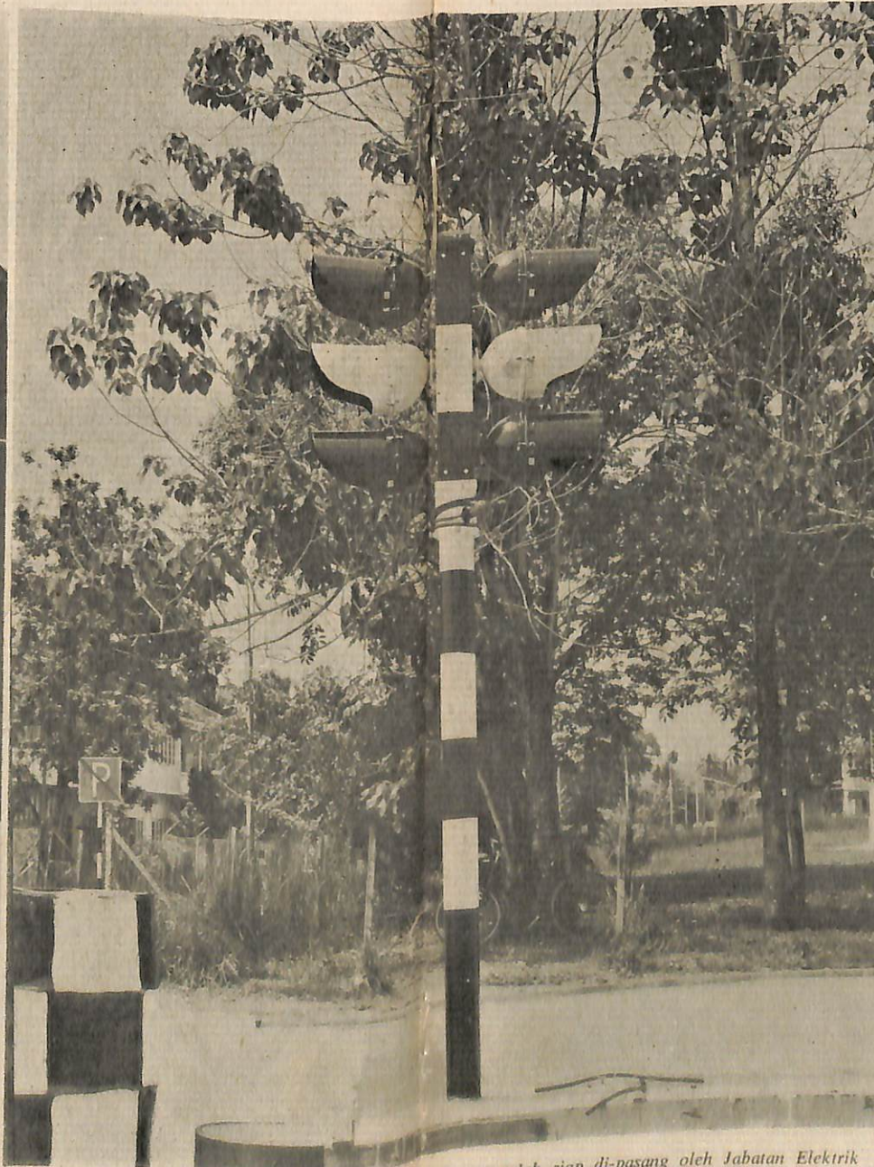
Satu pemandangan tiang dan lampu2 lalu lintas yang telah siap di-pasang oleh Jabatan Elektrik Negeri Brunei di-simpang sa-buah jalan raya di-Bandar Brunei.
