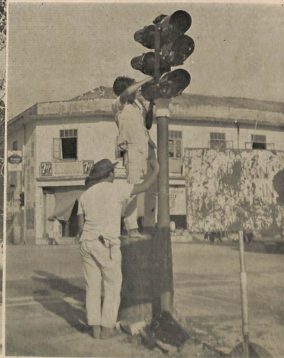
Anggota2 dari Jabatan Elektrik Negeri Brunei kelihatan pada masa mereka sedang memasang sa-buah lampu lalu lintas di-simpang Jalan Sultan dan Jalan Chevalier.
