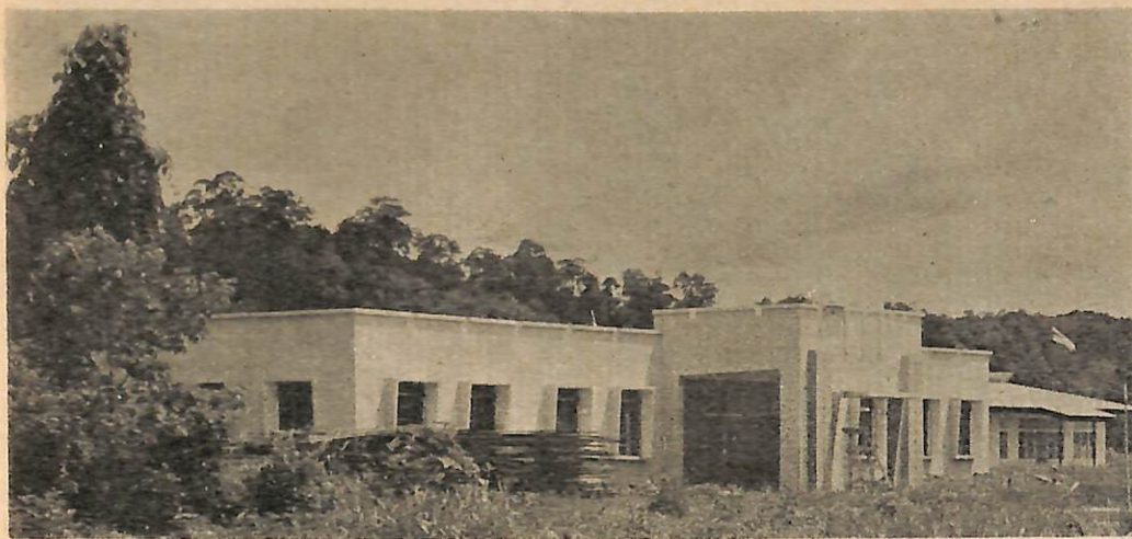
Gambar bangunan Balai Polis Labi.
