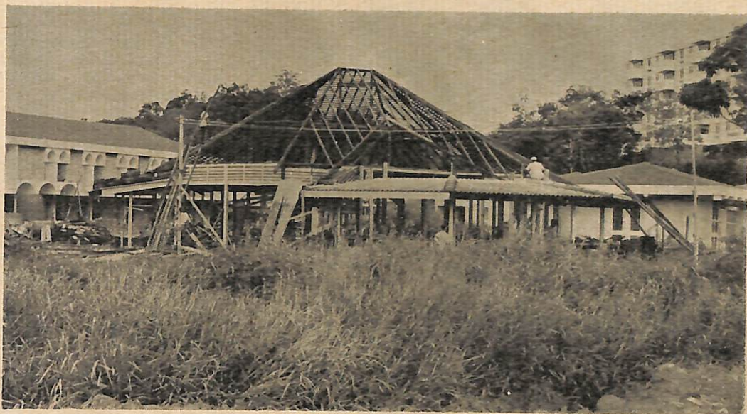
Gambar atas menunjukkan kerja2 meruboh bangunan Istana Yau-Mil-Hapidz-Dunya (Istana Parit) ia-itu bekas Istana Al-Marhum Duli Yang Maha Mulia Sultan Ahmad Tajuddin, Sultan Brunei yang ke-27. Tapak bangunan ini ia-lah bagi menempatkan pembenaan2 yang di-bawah ranchangan Jabatan Hal-Ehwal Ugama. Berdekatan dengan bangunan lama ini ia-lah bangunan asrama penuntut2 Sekolah Menengah Arab Perempuan Pengiran Anak Damit yang sedang dalam pembenaan.
