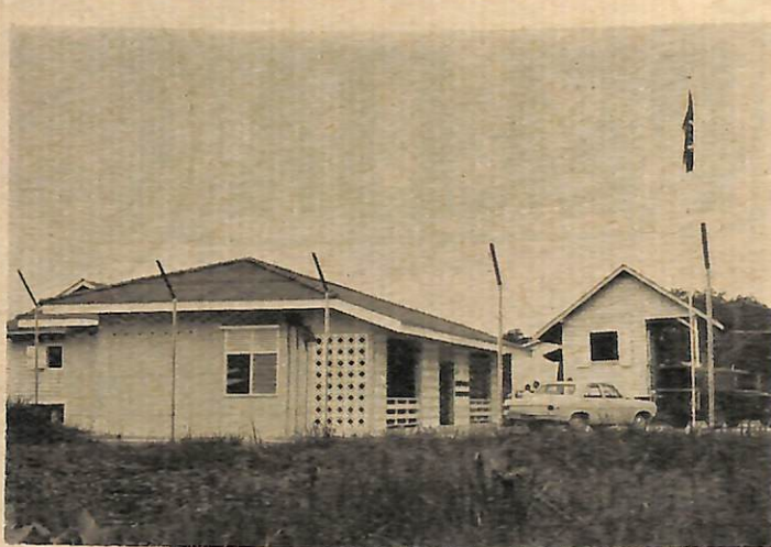
Gambar atas ia-lah bangunan baru Balai Polis di-Sengkurong bagi menggantikan bangunan lama (di-kanan sekali). Bangunan ini di-bena dengan bentok yang moden. Sa-lain dari bangunan ini, di-bena juga sa-direkt bangunan berek yang letak-nya di-belakang bangunan Balai Polis itu.
