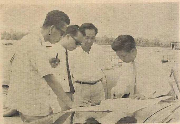
Gambar atas menunjukkan Yang Amat Berhormat, Pemangku Menteri Besar (di-sabelah kiri sekali) sedang mengikuti penerangan dari Pegawai Daerah Belait, Pengiran Momin mengenai dengan pembinaan bangunan Sekolah Pertukangan di-Kuala Belait. Sekolah tersebut akan di-bina di-kawasan lapang yang kelihatan di-belakang mereka. No. 2 dari kiri ia-lah Pemangku Pesuruhjaya Kemajuan Awang Zakaria dan di-sabelah beliau ia-lah Jurutera Kanan Jabatan Kerja Raya, Awang Wong Chow Kee.
