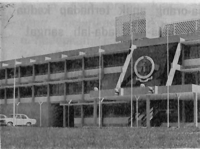
Bangunan Ibu Pejabat Pulis Di-Raja Brunei di-Gadong.
