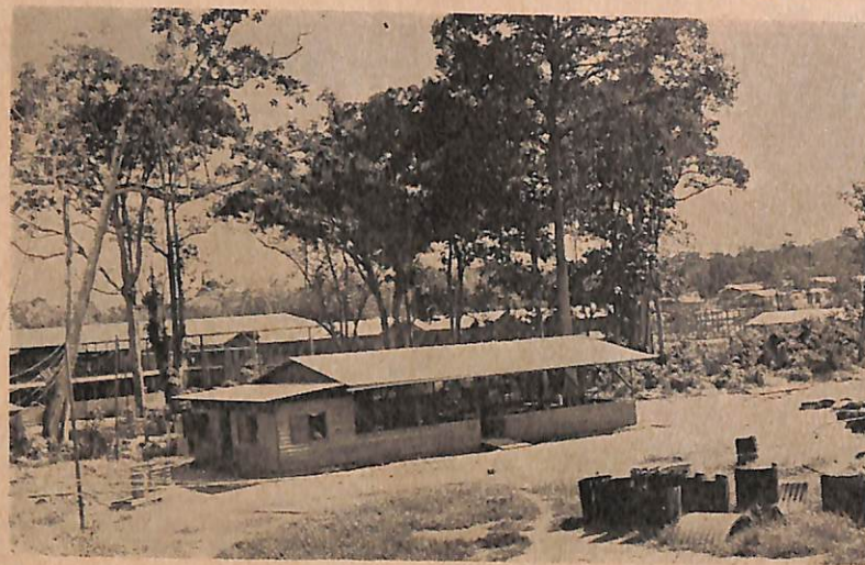
Kawasan Pekan Bangar yang baru. Kerja2 untuk pembinaan rangkaian bangunan2 termasuk rumah sakit, sekolah2 Arab, Pertukangan, jabatan2 Kerajaan, perumahan Kerajaan, pemancar radio dan lain-nya akan segera di-laksanakan.
