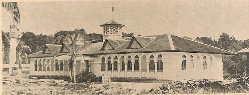
Pembinaan bangunan Pejabat Hal Ehwal Ugama, Tutong telah siap (gambar atas).
