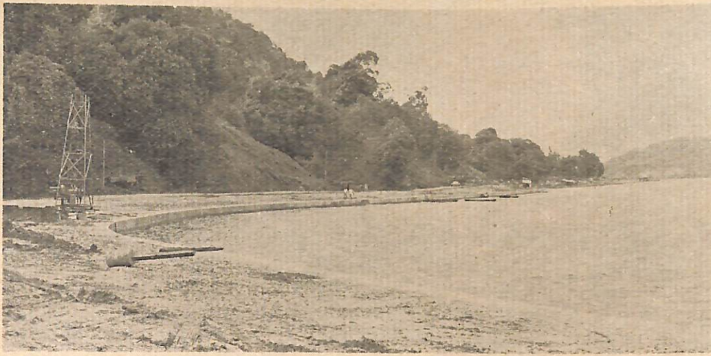
Pembinaan tembok di-sepanjang Jalan Residency telah selesai (gambar atas).
