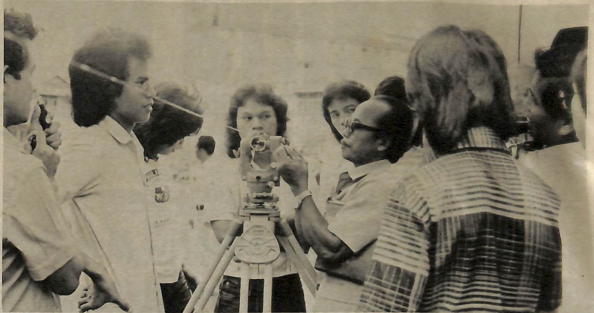
KELIHATAN penuntut2 sedang di-tunjokkan oleh Awang Tamit bin Nudin, Pembantu Teknik Jabatan Ukur, mengenai chara merantai dengan menggunakan alat 'Theodolite' dan sa-utas rantai yang di-buat daripada pita besi waja yang besarnya 1.59mm dan panjang-nya 110 meter yang di-tarek kapada satu tegangan 5km dengan menggunakan imbang spring.
