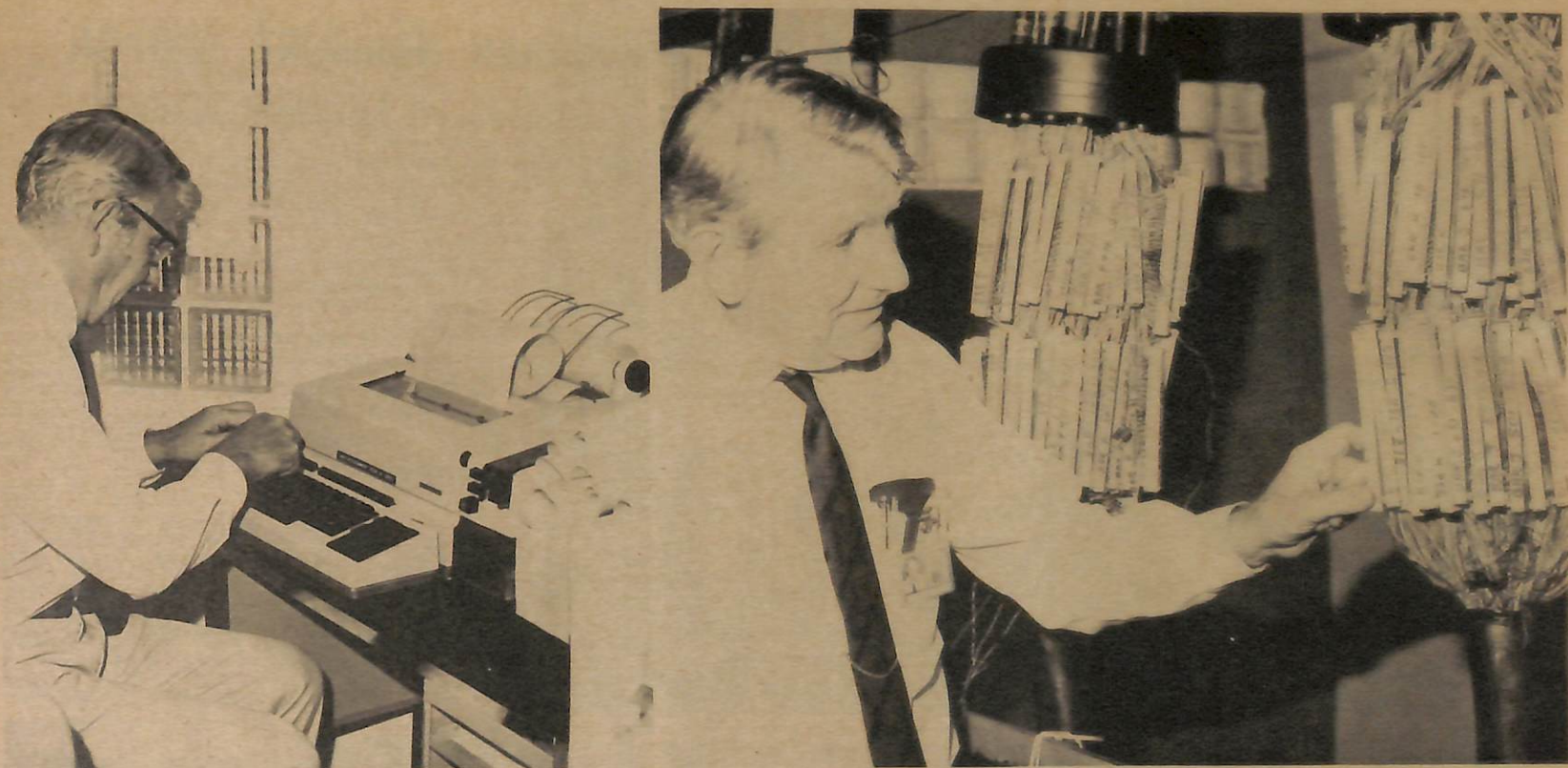
KELIHATAN Pengawal Talikom Brunei, Awang D.H.A. Scholey, sedang menghujkan penggunaan meshen telex ka-luar negeri, sementara gambar atas kanan pula beliau menerangkan beberapa ribu talian2 talipon yang telah siap di-pasang di-Bangunan Jabatan Talikom yang baru, Jalan Istana Darussalam, Bandar Seri Begawan.
