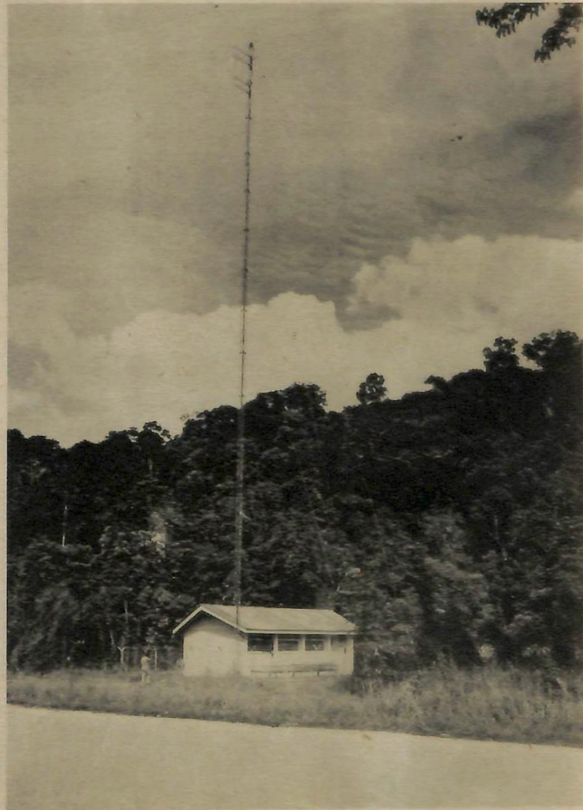
BANGUNAN "Exchange" yang memberikan kemudahan perhubungan di-daerah ini telah di-dirikan sejak lima tahun lalu.
