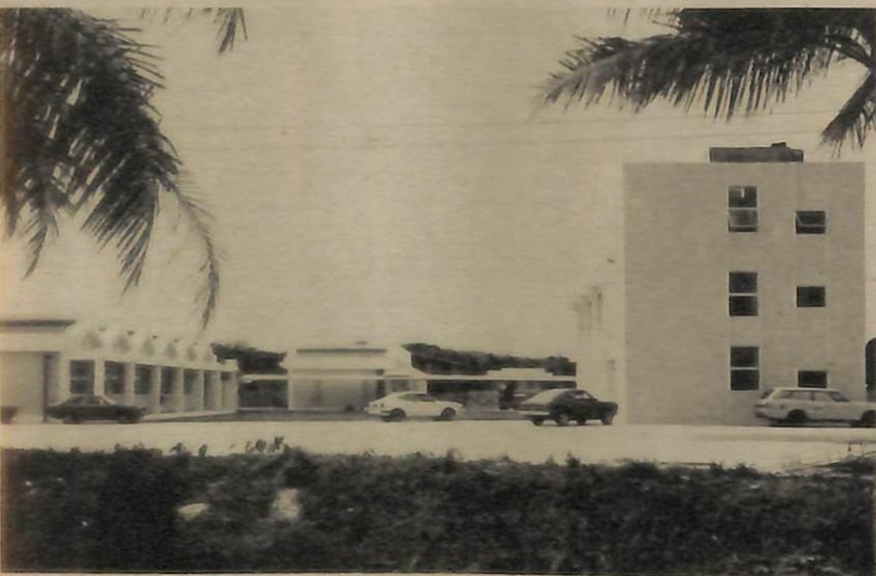
BANGUNAN Pusat Penyelidikan bertempat di-Steshen Pertanian Kilanas yang memakan belanja $1 juta.
