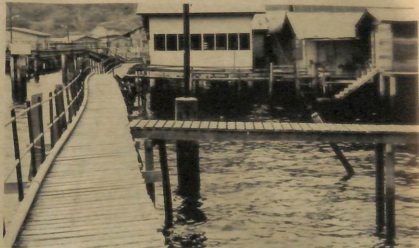
PENDUDOK2 di-Kampung Ayer juga tidak ketinggalan menikmati kemudahan yang disediakan oleh kerajaan. Seperti pembaikan jetty2 batu bagi kemudahan perhubungan penduduk2 sekitar Kampung Ayer ada-lah di-usahakan juga oleh Jabatan Daerah dengan bantuan penduduk2 kampung sa-chara gotong royong.
