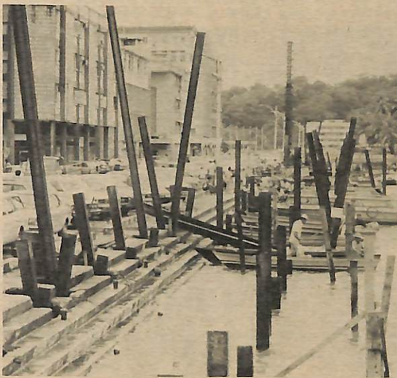
KERJA2 awal ka-atas projek pengaloran dan pembentokkan semula Sungai Kianggeh untuk menchantakkan Bandar Seri Begawan.
