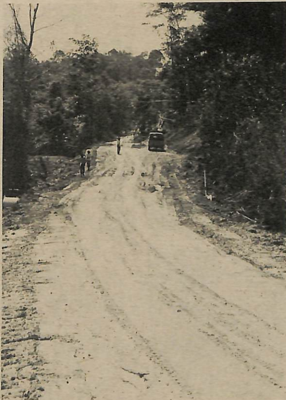
KERAJAAN Kebawah Duli Yang Maha Mulia melalui Jabatan Daerah telah membina beberapa batang jalan2 kecil di-kampung2 di-daerah ini. Kelihatan dalam gambar sa-bahagian dari jalan kecil yang sedang pembinaan yang menghubungkan antara Kampung Sungai Akar dan Mabohai.
