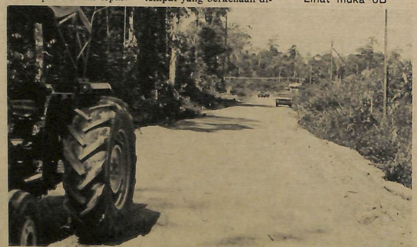
DI-SAMPING pembangunan pesat di-kawasan2 bandar, pembangunan luar bandar daerah ini juga di-ambil perhatian berat. Jalan2 kecil (seperti kelihatan gambar atas) di-bena bagi kemudahan2 penduduk2 kampung di-pendalaman.
