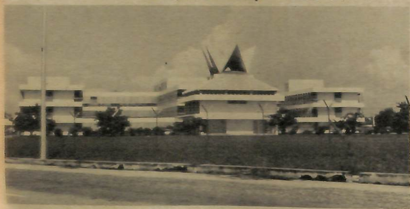
Bangunan Rumah Sakit Suri Seri Begawan, Kuala Belait.
