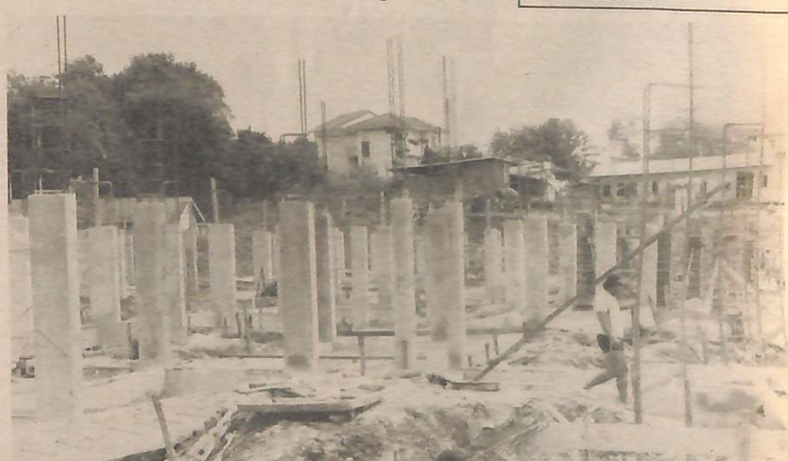
KERJA2 awal ka-atas tapak pembenaan pusat membeli-belah di-Kampong Lambak seperti kelihatan dalam gambar sedang berjalan dengan lancar.
