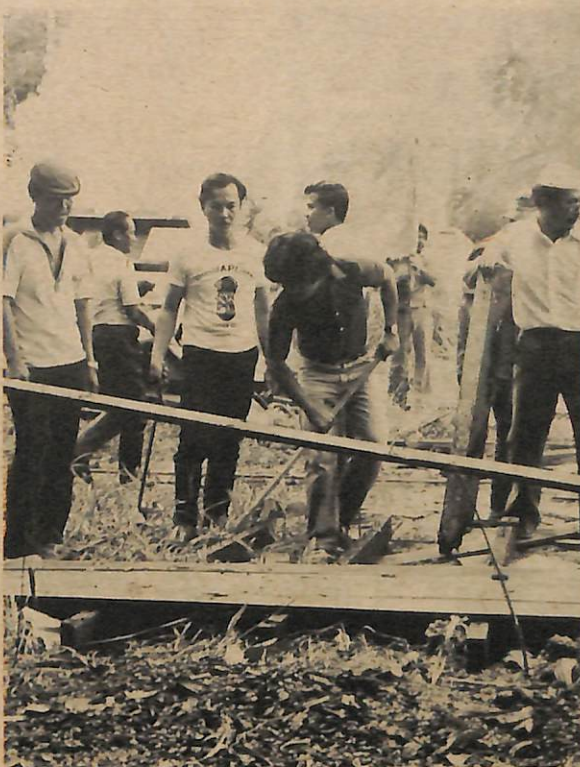
GAMBAR atas menunjukkan ketika kerja2 meroboh bangunan masjid lama dan membersihkan kawasan sedang di-jalankan.
