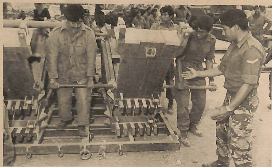
KELIHATAN empat orang ahli Skuadron Jurutera Pengempor sedang mengangkat salah satu bahagian Jambatan Medium Girder Bridge (MGB) semasa membuat Latehan Dingin Satu di-Hongkong. Kelihatan juga salah sa-orang Jurulateh dari Skuadron Jurutera Pasokan Gurkha Baginda Queen sedang memberi arahan.
