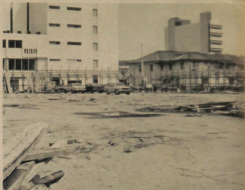
KERJA2 pembenaan bangunan letak kereta bertingkat telah di-mulakan di-atas tapak yang dulu-nya di-gunakan untuk perhentian bas dan teksi di-Jalan Cator.
