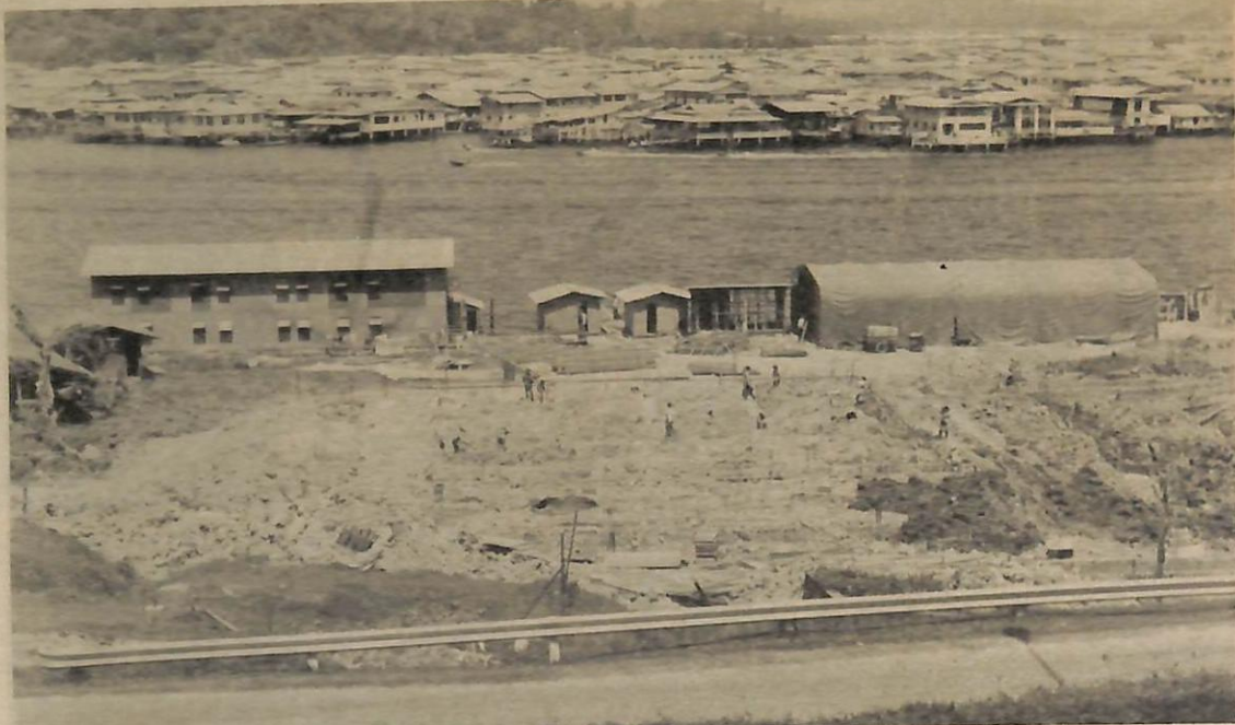
Kerja2 asas bagi bangunan Pusat Kesenian dan Pertukangan Tangan Brunei telah pun selasai di-jalankan. Tapak sa-luas tiga ekar itu terletak di-Jalan Residency menghala ka-Sungai Brunei (gambar atas). Sementara gambar bawah menunjukkan bentuk bangunan pusat tersebut apabila siap nanti.
