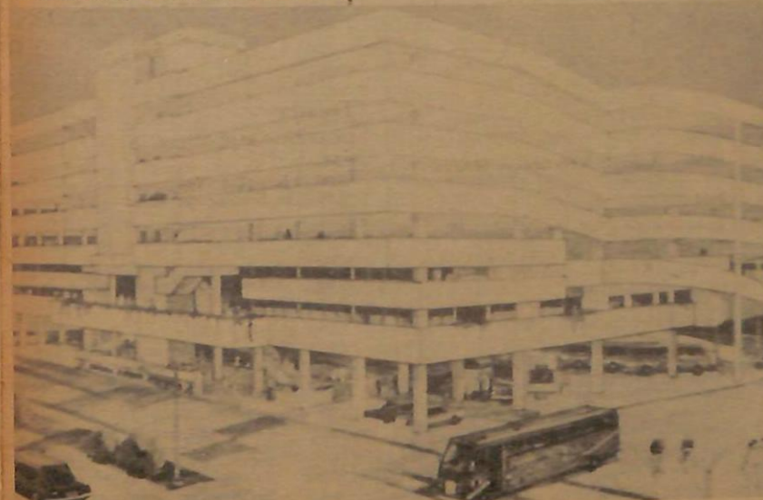
Letak kereta bertingkat dalam pembinaan yang dirancang bagi mengatasi kesibukan.
