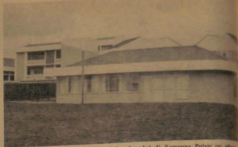
BANGUNAN Kebajikan bagi kanak-kanak nakal di Kampung Pulauie ini untuk pemulihan akhlak kanak-kanak yang terlibat dalam 'kenakalan remaja'.
