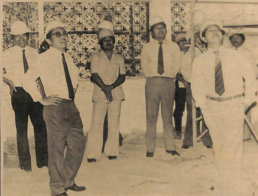
Bangunan Pusat Kesenian dan Pertukangan Tangan yang kini sedang dalam pembinaan telah 80 peratus siap. Bangunan yang terletak di Jalan Residency itu dianggarkan berharga 25 juta ringgit Brunei dan dijangka boleh digunakan dalam bulan Ogos tahun ini.
