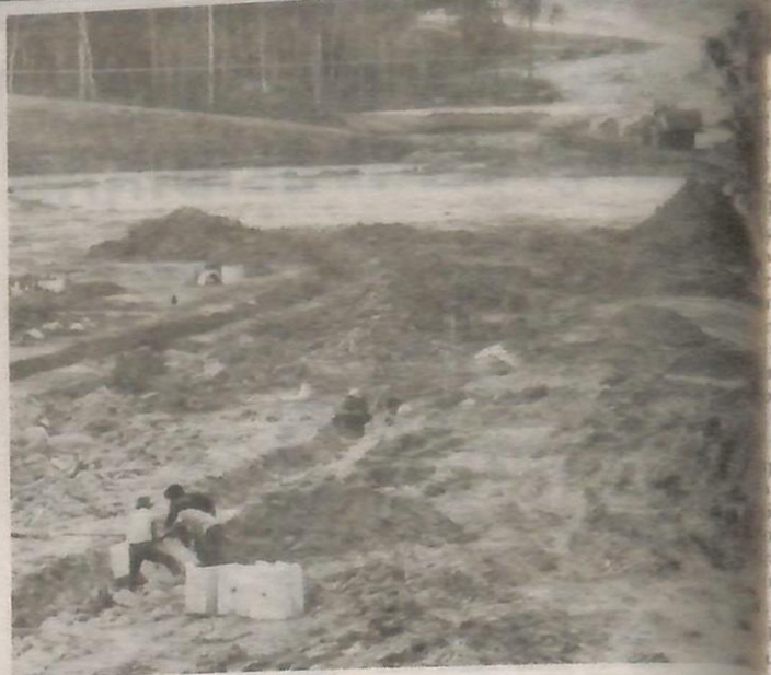
Kerja-karya infrastruktur sedang giat dilaksanakan di tapak perpindahan
