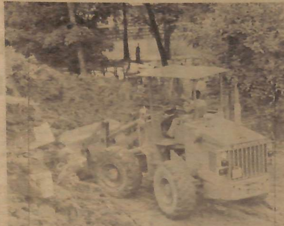
JENTOLAK dari Jabatan Kerja Raya sedang membersihkan tanah-tanah dan lumpur yang runtuh dan menimpa Jalan Tutong.
