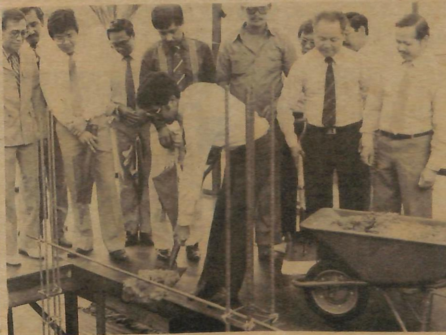
KELIHATAN Pengarah Kerja Raya, Yang Berhormat Pengiran Dr Ismail bin Pengiran Haji Damit sedang menuang konkrit bagi menandakan bermulanya kerja-kerja pembinaan bagi bangunan tersebut.
