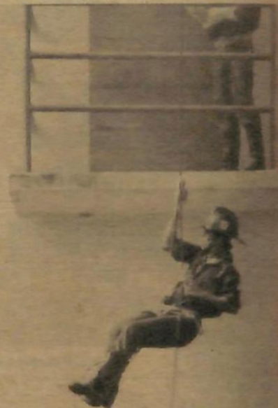
'PASUKAN PENYELAMAT' iaitu satu unit cawangan khas yang ditubuhkan oleh Pasukan Bomba mempunyai seramai 38 orang anggota ketika memperlihatkan aksi mereka turun dari bangunan yang tinggi dengan menggunakan tali.
