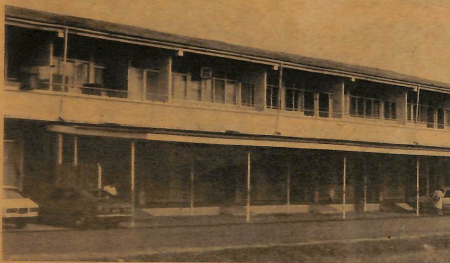
Bangunan PLKPTB yang terletak di Kampong Perpindahan Berakas yang digunakan dari tahun 1975 hingga 1983.
