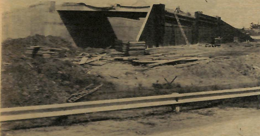
SALAH sebuah jambatan konkrit untuk lalulintas merentasi jalan masuk ke Jerudong Park sedang dalam pembinaan.
