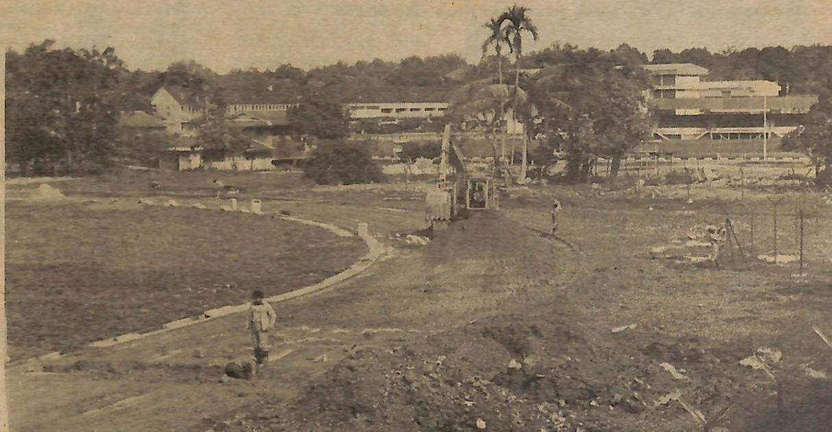
PEMANDANGAN sebahagian dari kawasan kompleks padang tersebut di mana Fasa I membuat kerja-kerja track dan pemasangan longkang sedang giat dijalankan oleh pekerja-pekerja kontrak yang terlibat.
