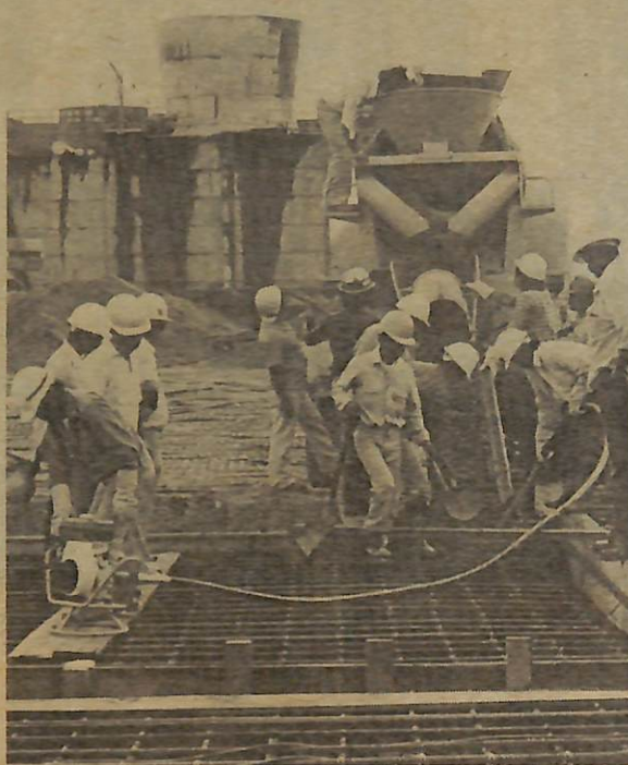
PEKERJA-PEKERJA sibuk menyediakan tapak bagi janakuasa tersebut.
