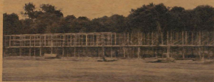
PEMBINAAN bangunan baru Sekolah Melayu Supon Besar sedang giat dilaksanakan. Projek ini menelan belanja $153,545.60.
