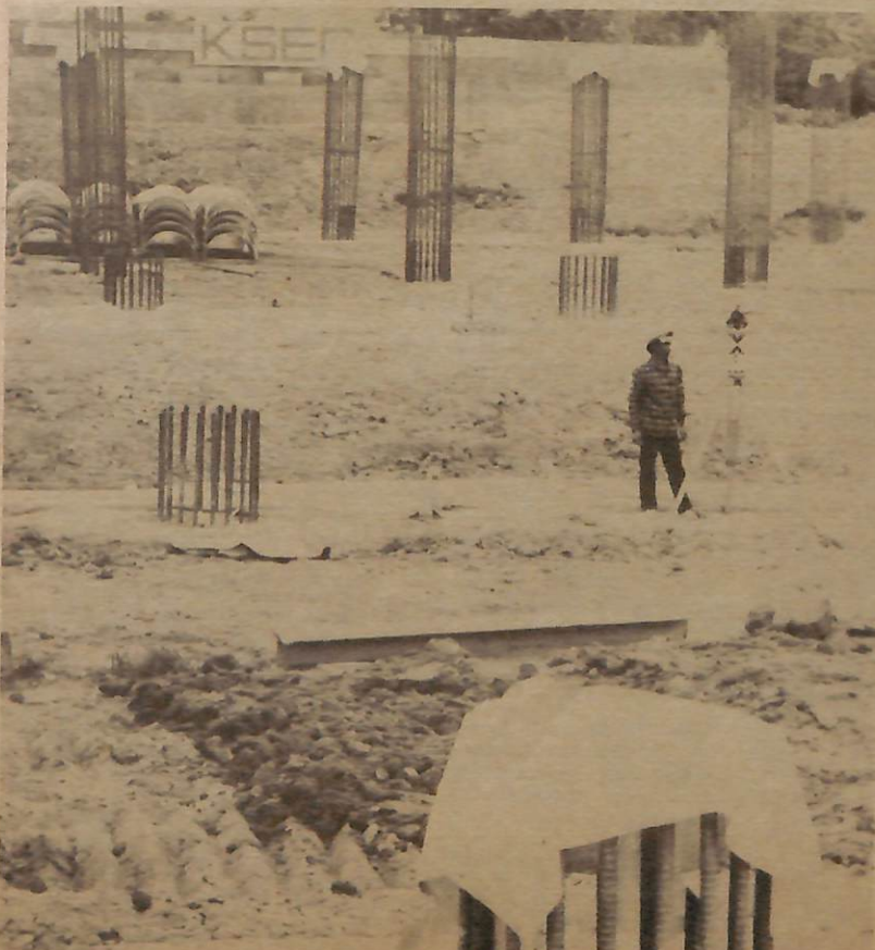
PEMBINAAN jejambat menyeberangi Jalan Lapangan Terbang Antarabangsa juga sedang dalam pembinaan.
