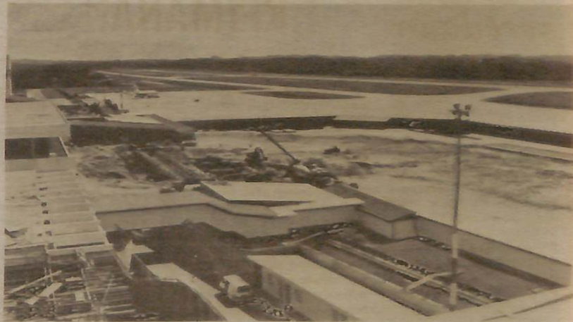
KERJA-kerja pembinaan ke atas bangunan restoran bagi orang-orang Islam sedang rancak dalam pembinaan.
