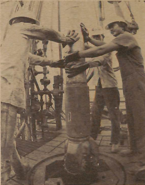
UNTUK mendapatkan sumber minyak memerlukan kepakaran ilmu teknologi yang tinggi di samping keperluan tenaga yang bukan sedikit.
