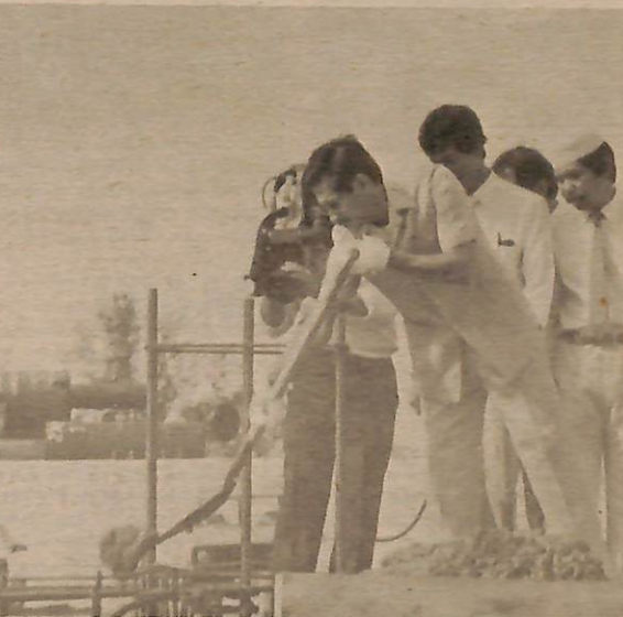
AWANG Haji Mohd Salleh bin Haji Hidup, Setiausaha Tetap Pentadbiran Kementerian Pembangunan meletakkan batu asas bagi Bangunan Pendaratan Ikan di Serasa. — Gambar oleh Ak Bahar PHO.
