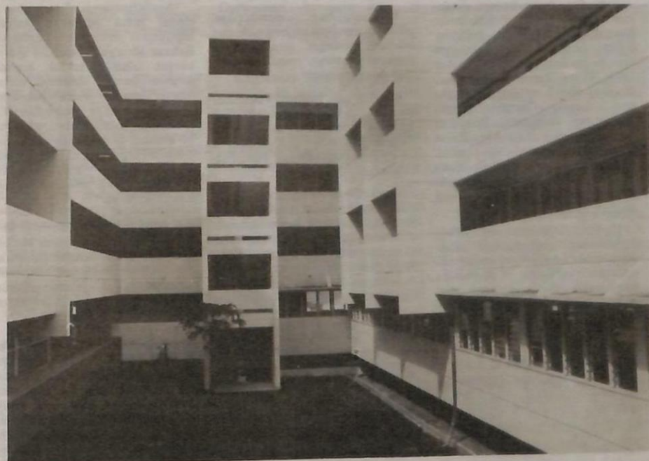
Bilik kuliah dan makmal komputer dan kejuruteraan elektrik dan elektronik terletak di tingkat dua dan tiga bangunan Maktab Teknik Sultan Saiful Rijal, Jalan Muara.
