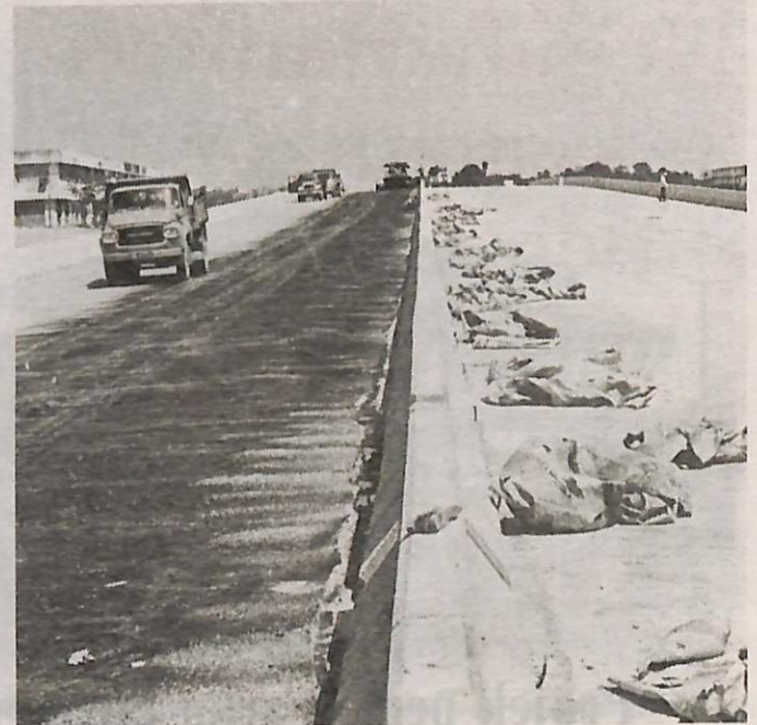
PEMANDANGAN dari atas, di mana kerja-kerja penyiapan hampir siap sepenuhnya.
