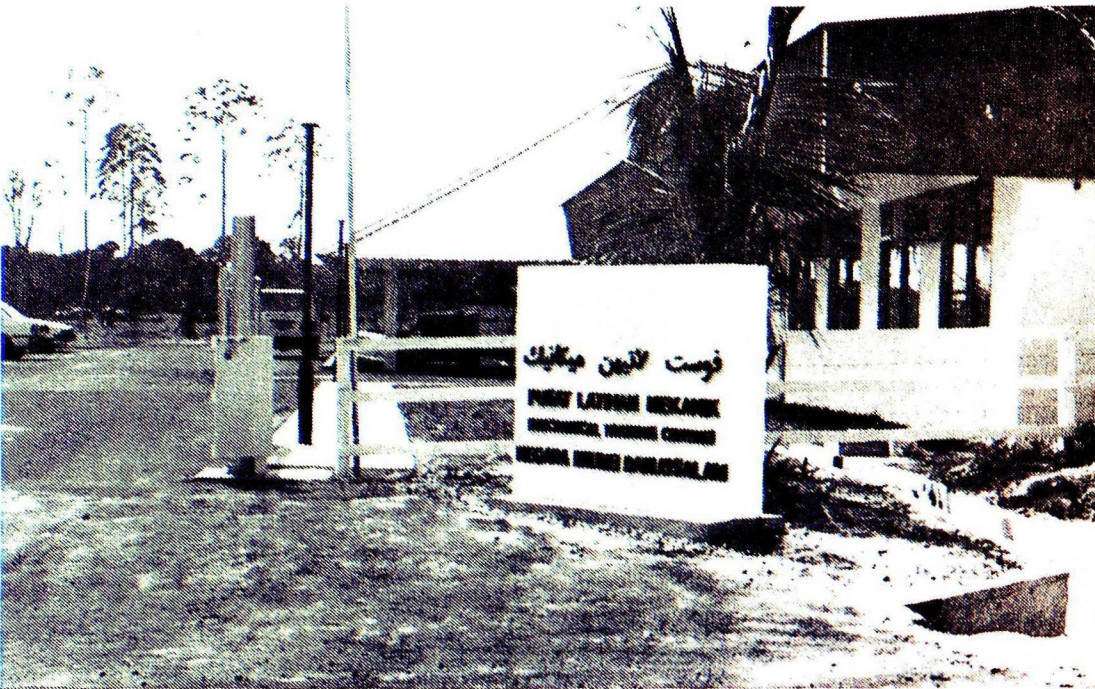
BLOK Pentadbiran Pusat Latihan Mekanik yang terletak di Jalan Tungku Gadong berdekatan dengan bangunan McFarm.
