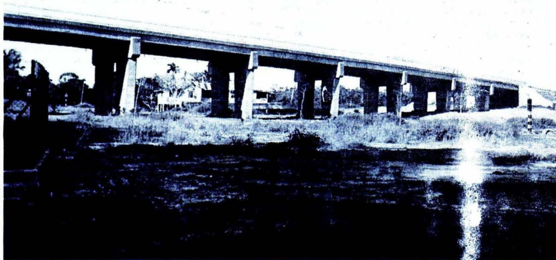
DALAM pembinaan lebuhraya sebanyak sembilan buah jambatan telah didirikan seperti kelihatan dalam gambar.
