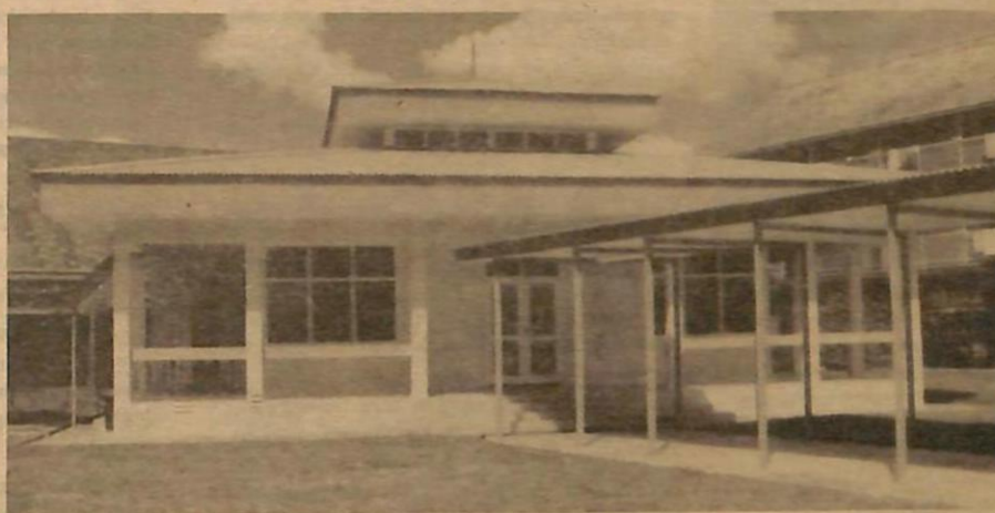
BANGUNAN Surau Maktab Sultan Omar Ali Saifuddin yang terletak di antara bangunan asrama dan maktab itu. — Gambar oleh Pg. Abu Bakar PHO.
