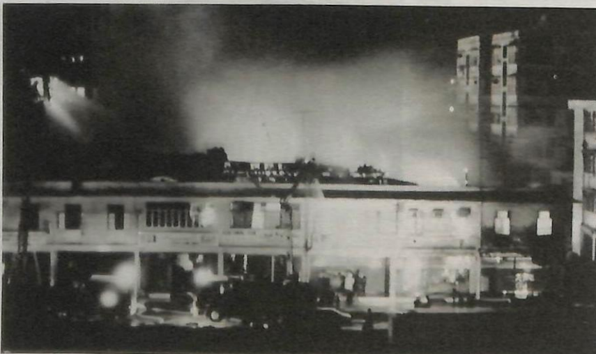
INILAH kejadian kebakaran yang memusnahkan lima unit dari tujuh unit kedai di Jalan Pemanca di ibu negara malam Ahad lalu. — Gambar oleh Haji Sharbini Taha.
