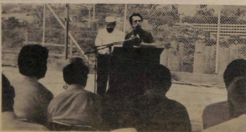
DATO Paduka Awang Haji Chuchu, Setiausaha Tetap Kementerian Perhubungan ketika berucap di Majlis Meletakkan Batu Asas bagi bangunan tambahan Rumah Telefon, Jabatan Telekom. Di belakang kelihatan kerja-kerja sedang dijalankan di mana terletak bangunan baru itu nanti. — Gambar oleh Harun Rashid.
