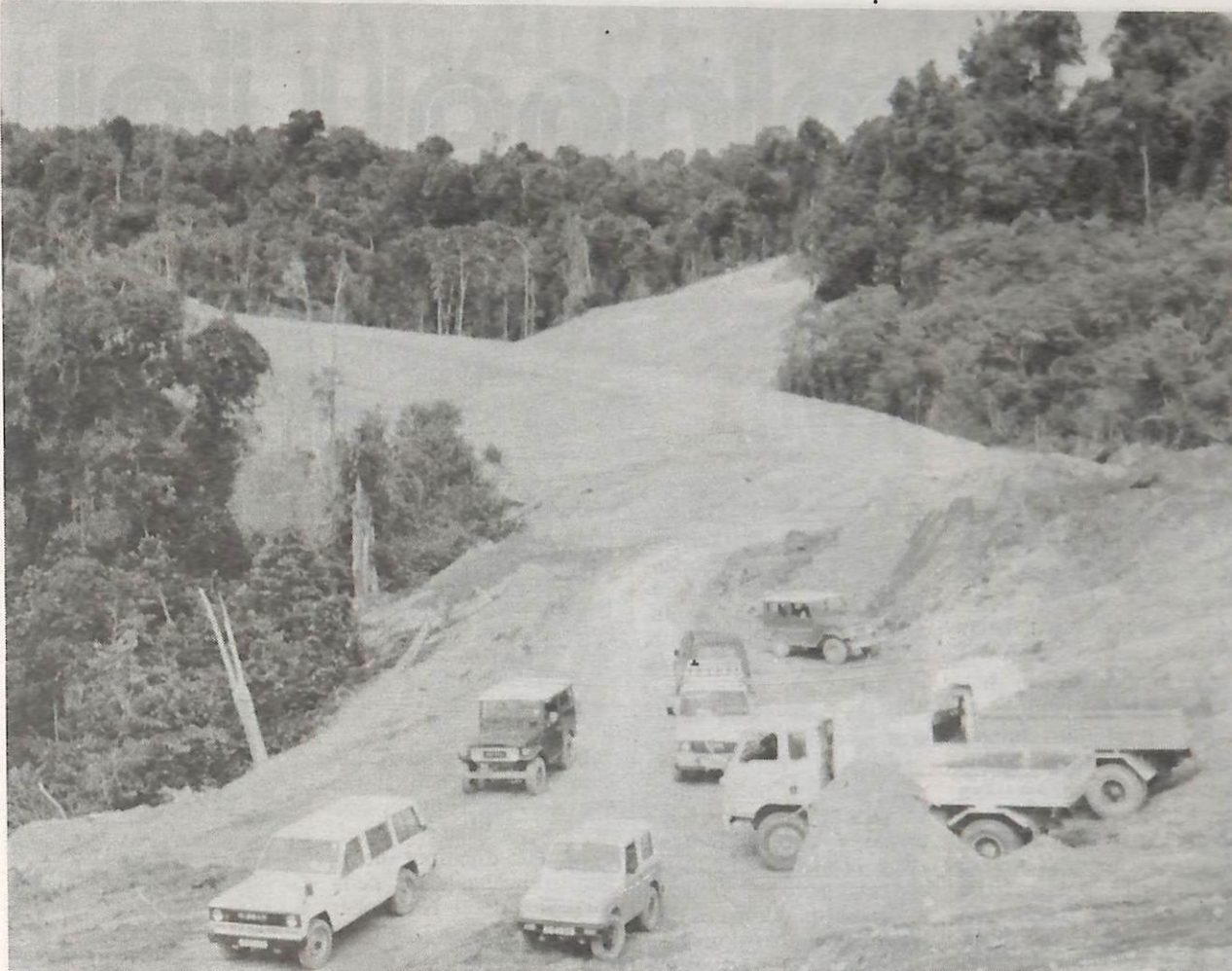
KERJA-KERJA meratakan tanah dan meruntuhkan bukit bagi projek lebuh raya
