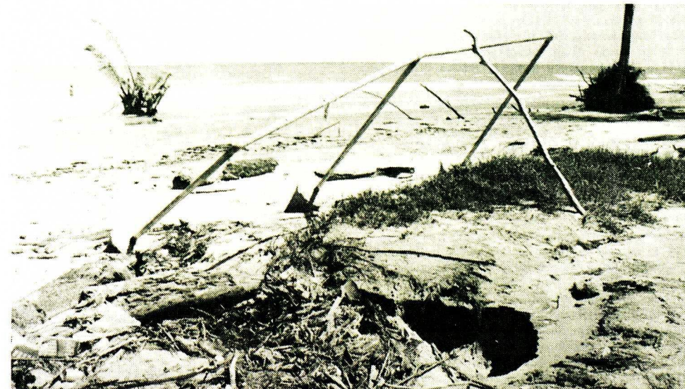
LIHATLAH kawasan ini suatu masa dulu adalah tempat permainan yang dibina di salah sebuah pantai peranginan, tetapi kerana hakisan air dan ombak tidak mengenal ampun, ianya turut musnah senasib dengan pasir pantai yang semakin hilang.
